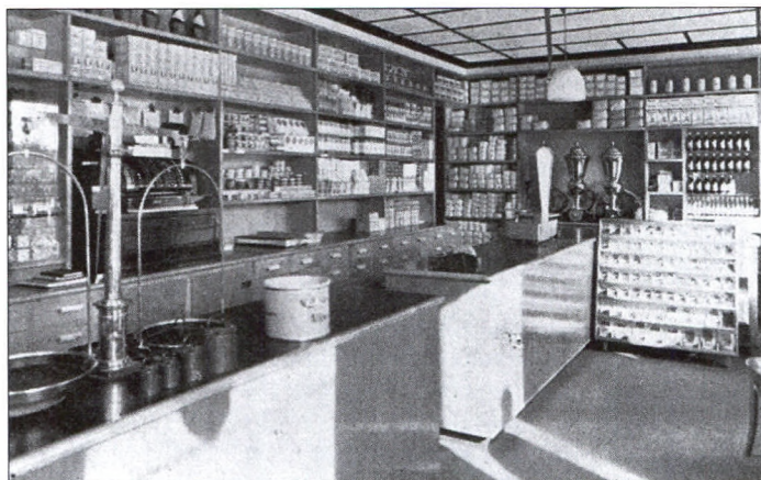
Butikslokalet fra A. J. Gerstrøm og P. V. Lüneborgs tid.
