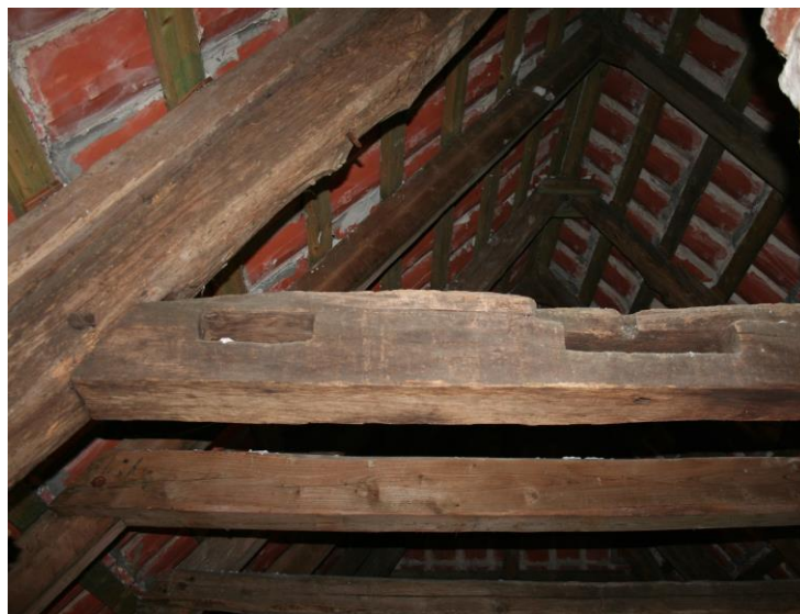
Figur 12 Figuren viser et udsnit af noget af det genbrugstrømmer der findes i tagkonstruktionen.
