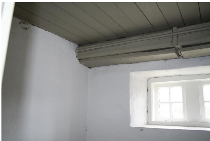
Figur 4 Her ses det at jernstangen der forbinder det nordligste muranker i øst og vest går igennem rum 0.3.
