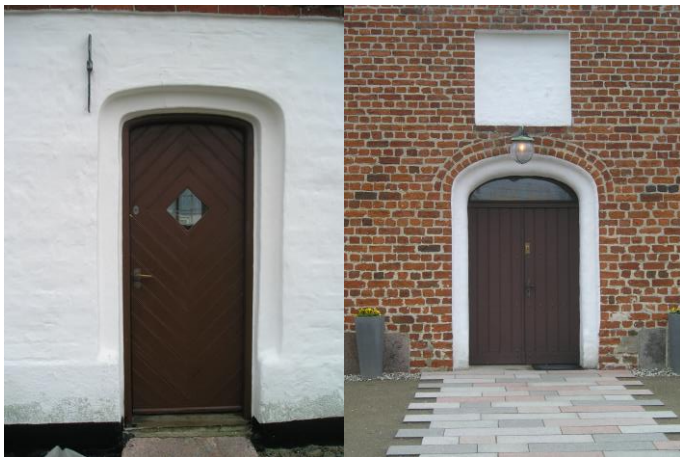
Figur 5 Her ses henholdsvis hospitalets nuværende indgangsdør samt døren til kirkens våbenhus. Begge med kurvehanksbuet åbning.
