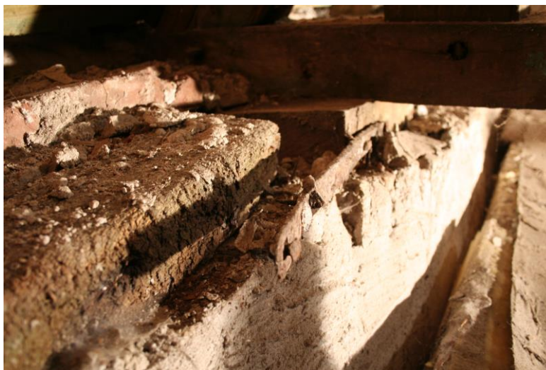
Figur 11 På figuren ses remmen, som spærene hviler ovenpå og hvorledes denne består af flere stykker træ der holdes sammen af et jernbeslag.
