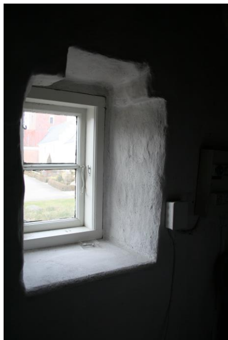
Figur 8 På figuren ses det nordligste vindue i vestvæggen. Dette er det ene ud af to vindue i bygningen uden en træoverlægger, og det antages dermed at være blandt de ældste.
