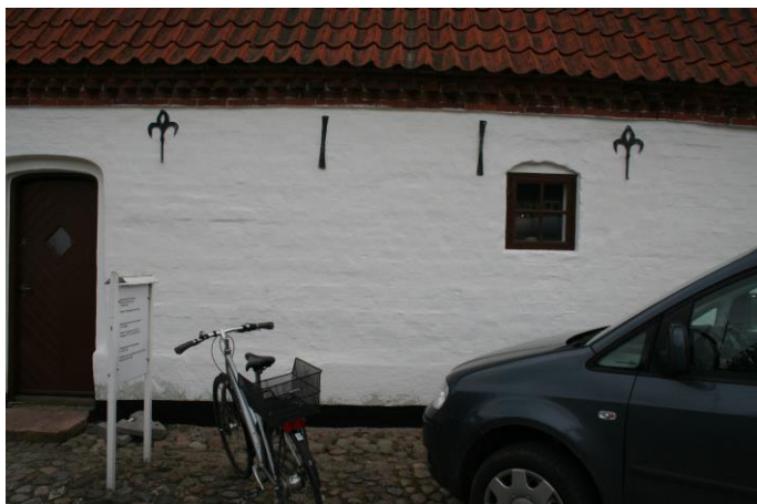
Figur 14 Figuren viser den midterste del af vestfacaden og de to ”J”- lignende murankre
