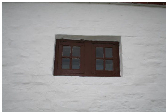
Figur 7 Her ses det eneste vindue i rum 0.3 og i den nordlige facade. Dette er det andet ud af to vinduer i bygningen uden træoverlægger og det antages dermed at være blandt de ældste dele af huset.
