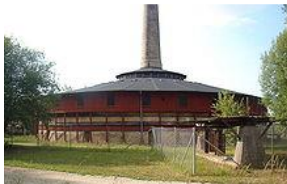
Nivaagaard Teglværks ringovn (herover) og ringovnen på Floes Teglværk har haft stort set samme størrelse. Nivaagaard Teglværks ringovn blev i 1978 restaureret og fredet i 1985.
