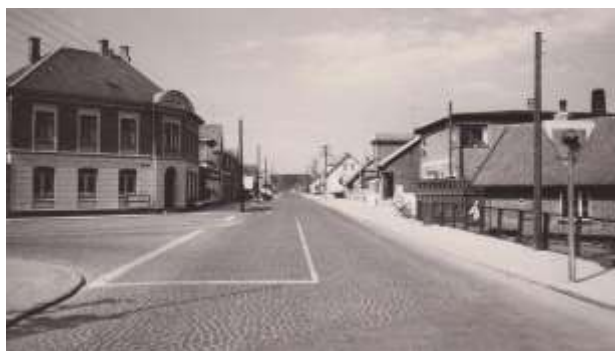
Landevejen med brobelægning. Den første asfaltering blev lagt oven på brostenene, men kunne ikke holde. Hele vejen blev brudt op og brostene fjernet og en ny tæppebelægning kom på.
